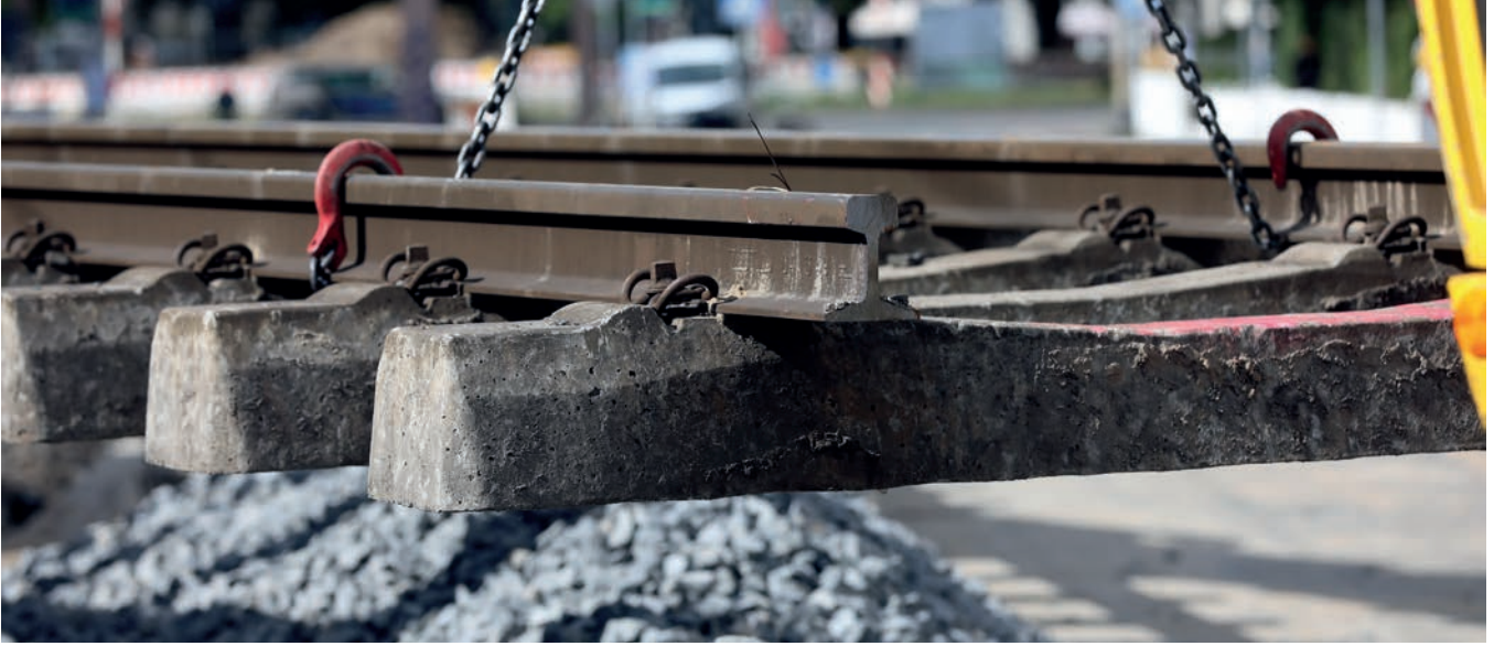
Die Pflege und der Ausbau von Gleisanlagen gehen auch in 2021 voran.
