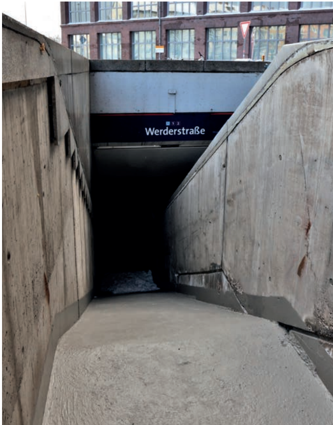
Die frisch beschichtete Grube ist bereit für die neue Fahrtreppe.
