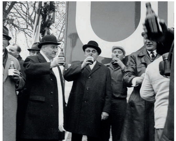
Zum Baustart des U-Bahn-Baus am Waterlooplatz gab es einen Umtrunk mit Oberbürgermeister August Holweg (Mitte) und Ministerpräsident Dr. Georg Diederichs (links, weißer Schal) – Bier inklusive.
