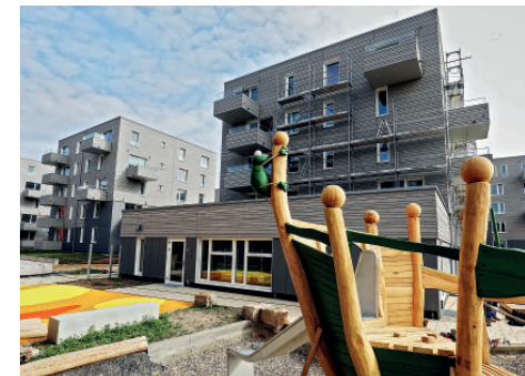
Insgesamt 139 Wohnungen und eine Kita entstehen auf dem ehemaligen Gelände des ÜSTRA Betriebshofs in Vahrenwald.
